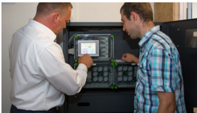
Der HMI/PLC XV102 lässt sich einfach über den Touchscreen bedienen, ein Laptop ist für die Konfiguration nicht notwendig.
